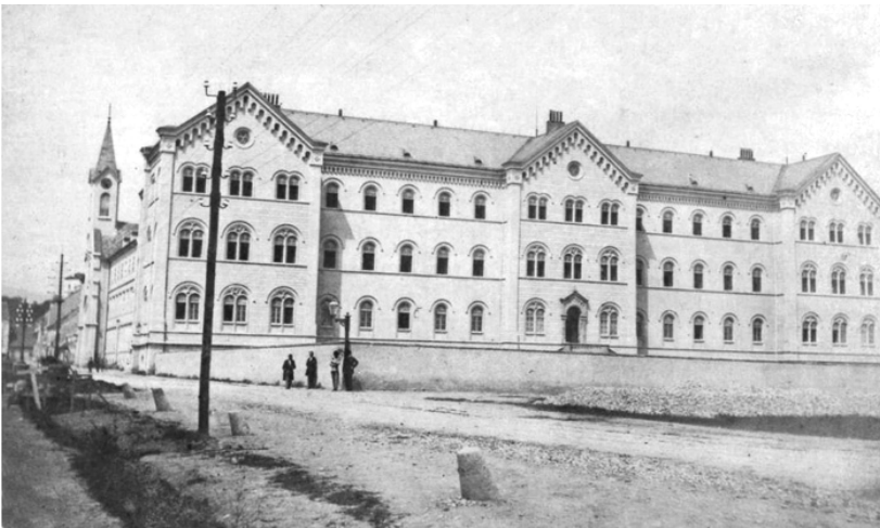
Pogled na pročelje zgrade 1864. godine dok je još postojala ograda, koja je srušena 1882. zbog spajanja ulice Marovske (današnja Masarykova) i Prilaza (Gjure Deželića). Lijevo se vidi još uvijek otvoreno korito potoka Tuškanac.
