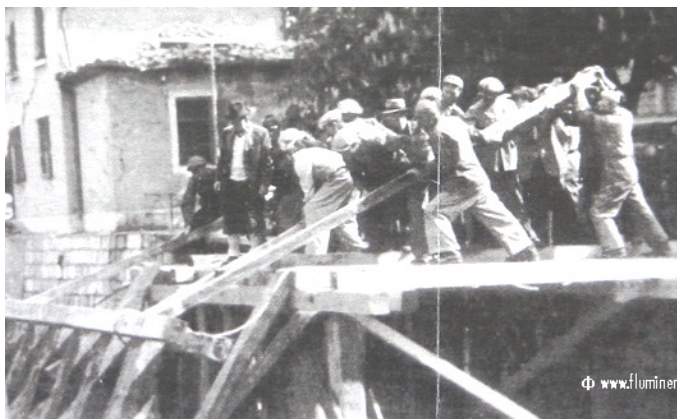
Podizanje drvenog mosta preko Rječine 4./5. svibnja 1945. prema zamisli Maksa Peča (u sredini sa šeširo) www.fluminer
