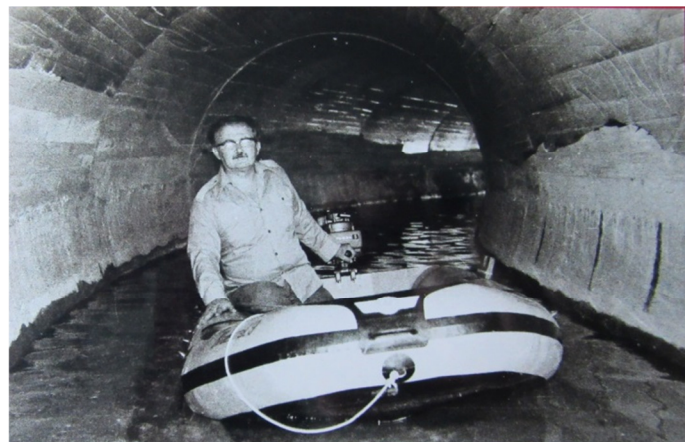
U pregledu kolektora Špansko
