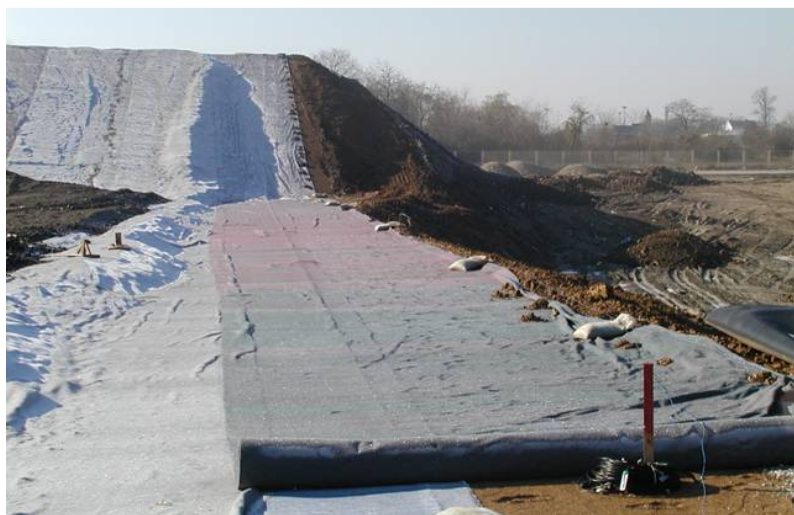
Odlagalište otpada Jakuševac
