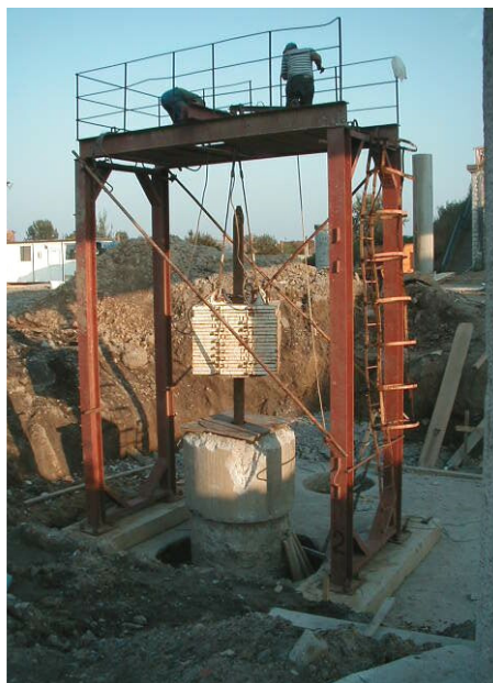
Dinamičko ispitivanje pilota na mostu Drežnik, autocesta Rijeka-Zagreb
