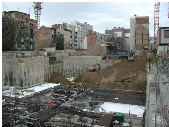
Građevna jama Branimir centra, Zagreb
