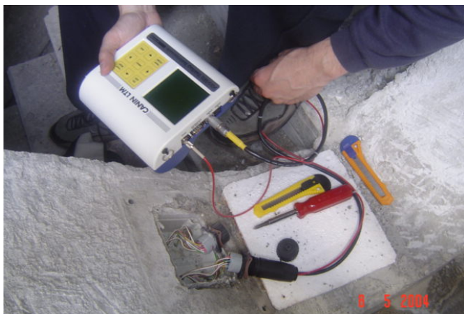
Korozijski monitoring na mostu Krka
