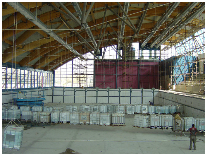
Ispitivanje krova bazena u Utrini
