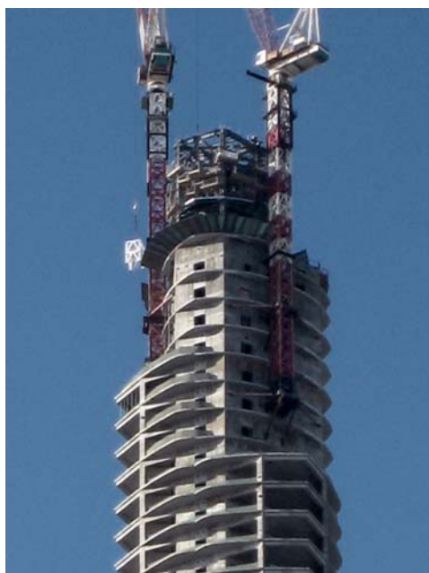
Završetak betonskog dijela konstrukcije zgrade
