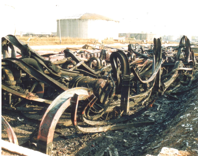
Slika 1. Posljedice djelovanja razornog požara na čeličnu i betonsku konstrukciju
