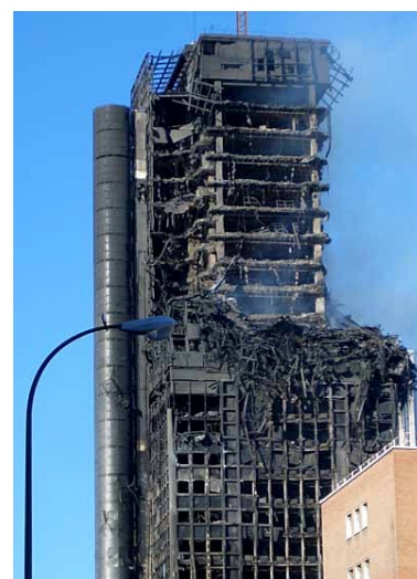
Slika 1. Posljedice djelovanja razornog požara na čeličnu i betonsku konstrukciju
