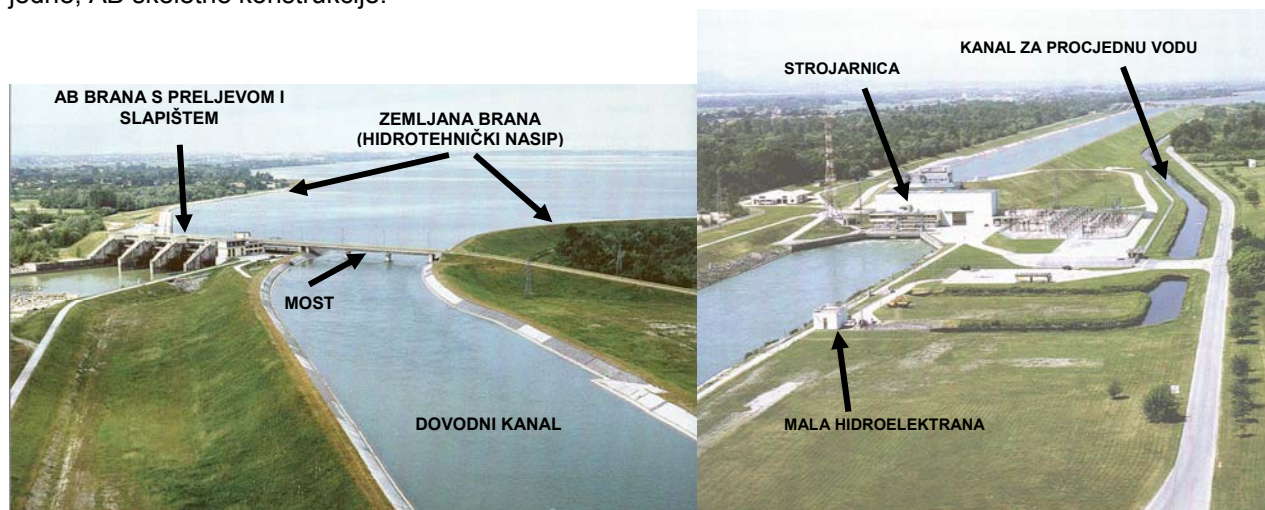
Slika 1.3.1::1 Primjer konstrukcija riječne hidroelektrane
