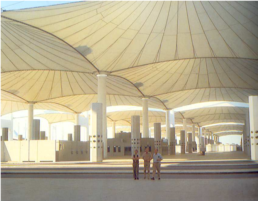
Slika 4: Haj Terminal u međunarodnoj zračnoj luci Jeddah. Saudijska Arabija, 1981. god. U tehnološkom smislu izvedba je brza i svodi se na montažu tvorničkih prefabrici-
