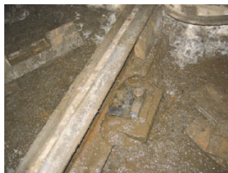
Slika 1. Degradacija tračnice uzrokovana gubitkom materijala na poziciji pričvršnog mjesta [3]
