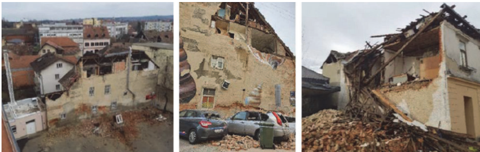
Slika 1. Otkazivanja zidova van ravnine u Zagrebačkom potresu 2020. godine [9]
