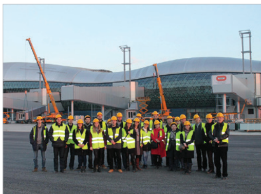
— Stručna ekskurzija na gradilište novoga terminala Zračne luke Franjo Tuđman koju je organizirala Udruga AMCA-FA
